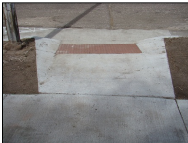
ADA Crosswalk Ramp
